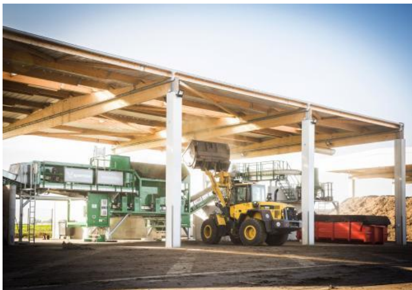
Le centre de compostage des végétaux
