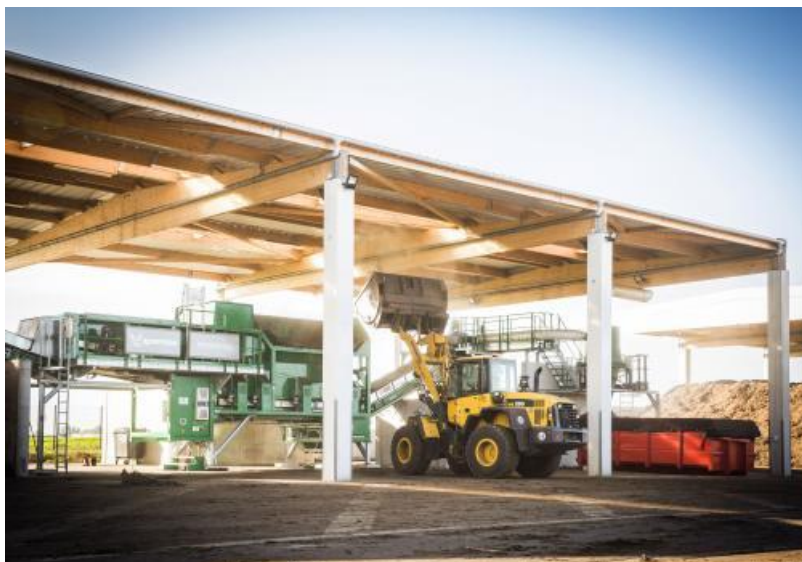
Le centre de compostage des végétaux
